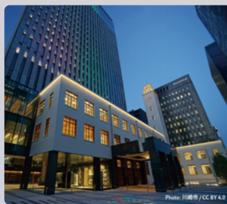
川崎市新庁舎本庁舎
